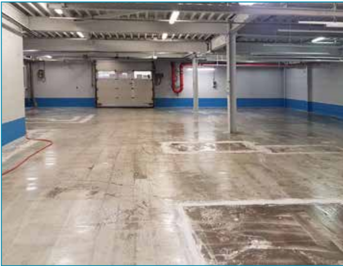
Grundierte, ausgeglichene Fläche | Primed, evened out surface
