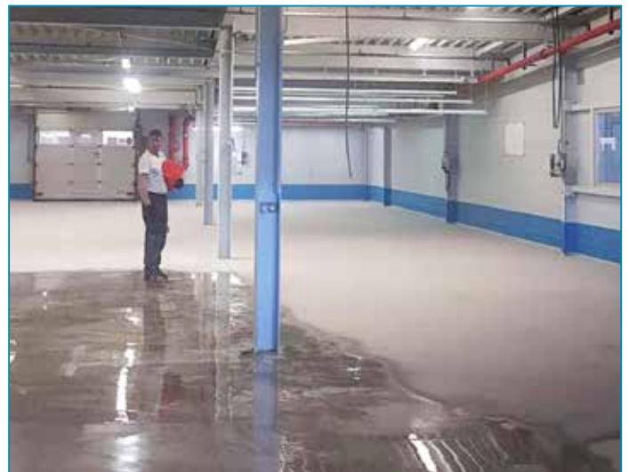
Auftragen der Zwischenlage | Application of intermediate layer
