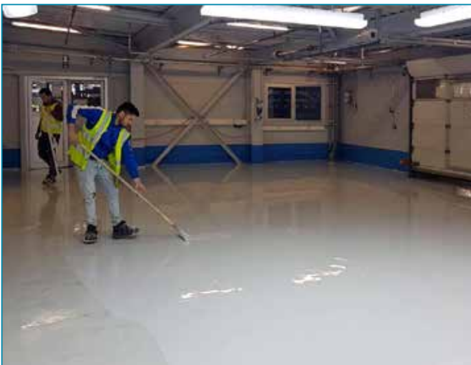
Auftragen der Zwischenlage | Application of intermediate layer
