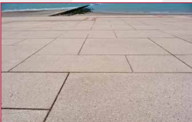
Betonsteinplatten im Großformat 120 x 120 cm, 60 x 60 cm und 120 x 60 cm / Concrete stone slabs in large format 120 x 120 cm, 60 x 60 cm and 120 x 60 cm
