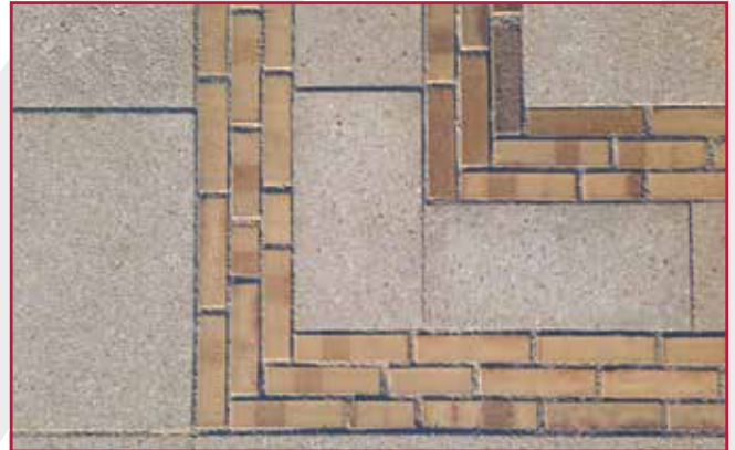
Unterbrechung der Großformate durch ein mäandrierendes Band aus Klinkerpflaster / Interruption of large format slabs by a meandering band of clinker paving stones
