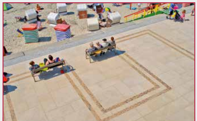
Die Verlegung der Platten war ein Kraftakt, ein Großformat wiegt bis zu 536 kg / Laying the slabs was not easy with each one weighing up to 536 kg
