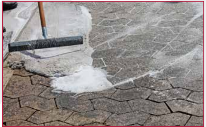
Nach der Reinigung wird mit dem Einschlämmen von ROMPOX®-D1 begonnen After cleaning, washing in of product commences
