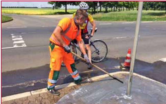
Unter den Augen interessierter Zuschauer werden die Verkehrsinseln verfügt Whilst passersby look on, the roundabouts are jointed
