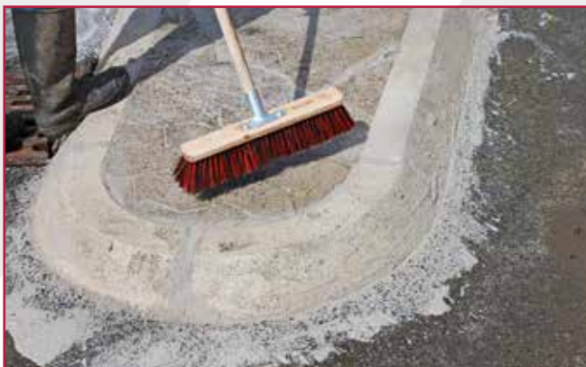
Die Fläche wird abschließend mit einem groben Besen gereinigt The surface is subsequently cleaned using a large broom
