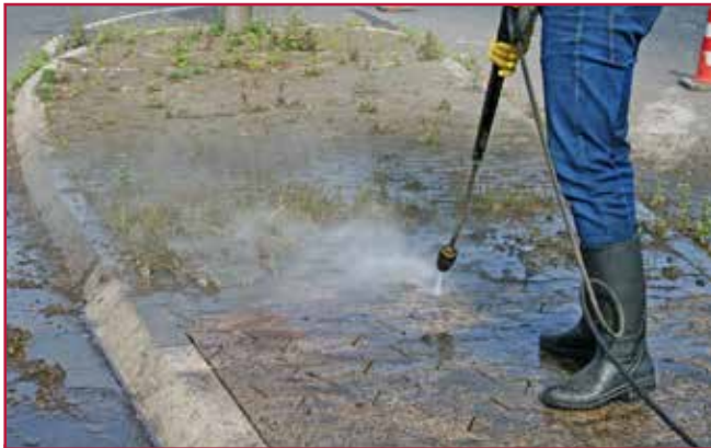
Die Fugen auf ca. 30 mm Tiefe reinigen The surface is cleaned using a high pressure cleaner
