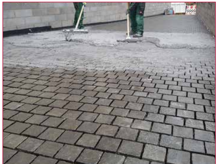
ROMPOX® - D1 verfugen | ROMPOX® - D1 jointing
