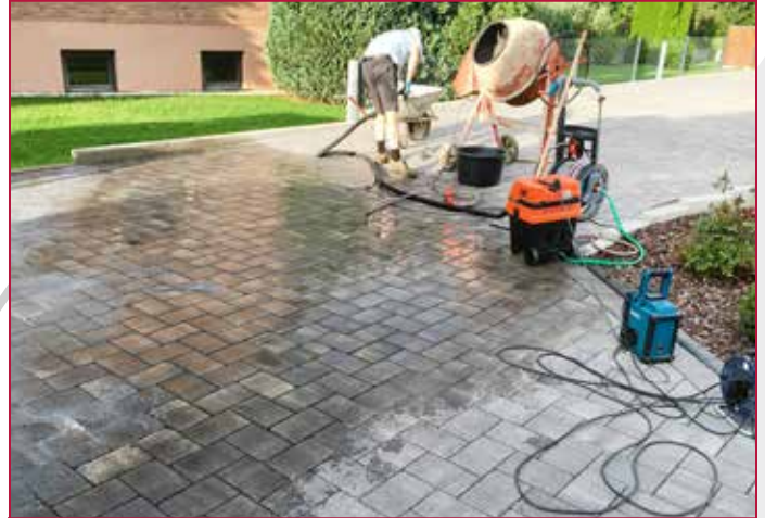
Mörtel anmischen | Mix the mortar
