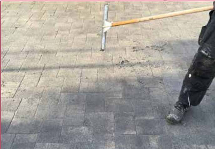
Mörtel einarbeiten | Work in the mortar
