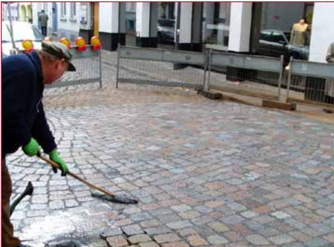
Verfugung mit ROMEX® - Pflasterfugenmörtel Jointing with ROMEX® pavement fixing mortars
