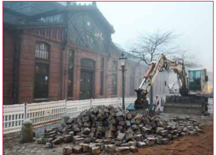
Rückbau der Fläche Reconstruction of surface
