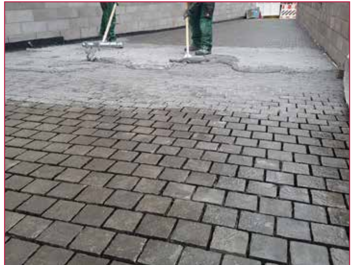
ROMPOX® - D1 verfugen | ROMPOX® - D1 jointing
