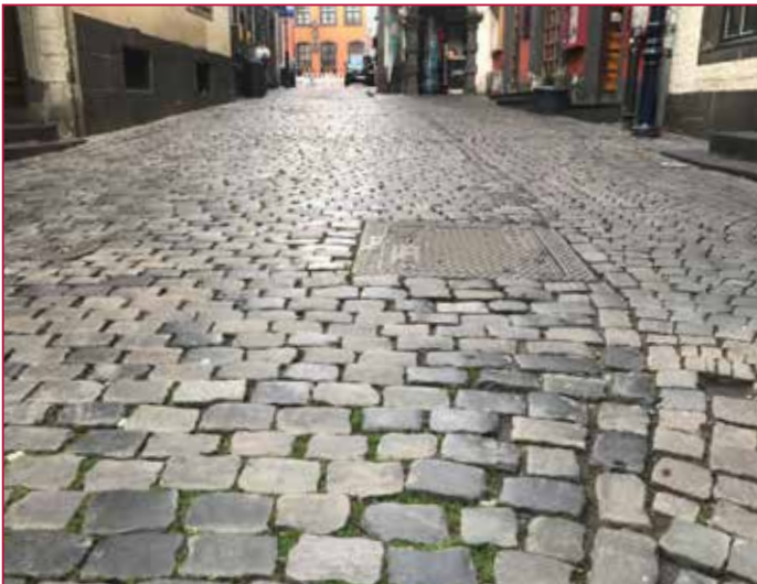
Kölner Salzgasse vor der Sanierung
