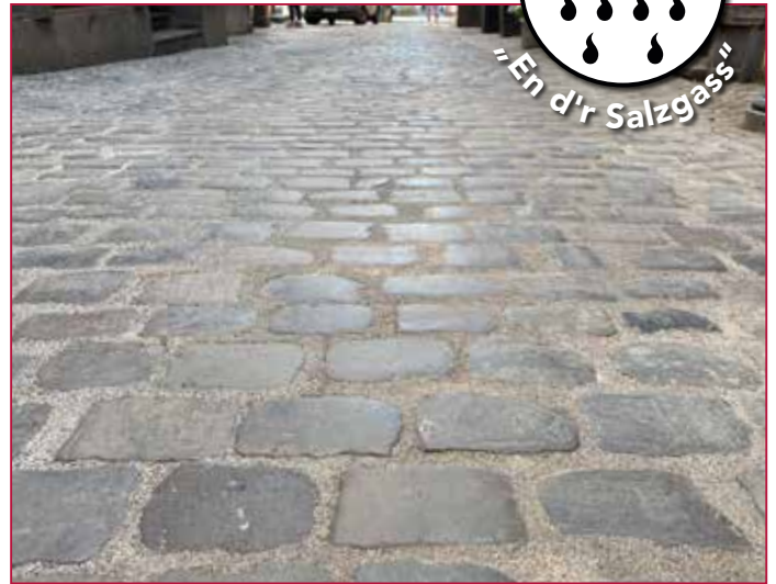
Nachher: Trittsicher und hochdruckreinerbeständig
