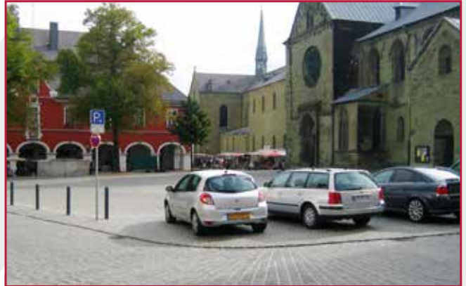
Der Petrikirchhof nach der Verlegung mit ROMPOX® - D2000 The Petrikirchhof after jointing with ROMPOX® - D2000
