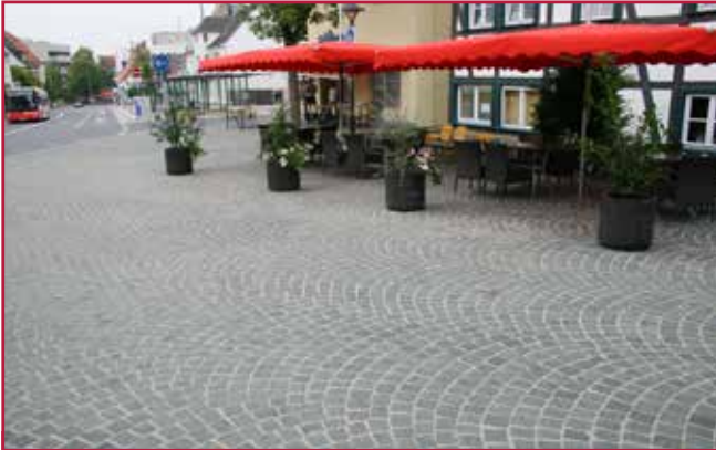
Der Hansaplatz nach der Verlegung mit ROMPOX® - D2000 The Hansaplatz after jointing with ROMPOX® - D2000
