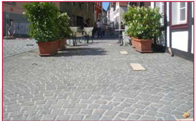
Detailansicht der neuen Verlegung Detailed view of the new joints
