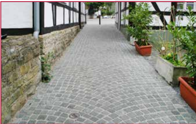
Auch die angrenzenden Gassen wurden saniert The adjacent streets were also repaired
