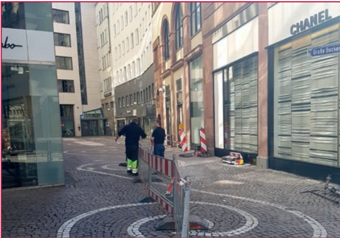
Baustellen Vorbereitung | Building site preparation
