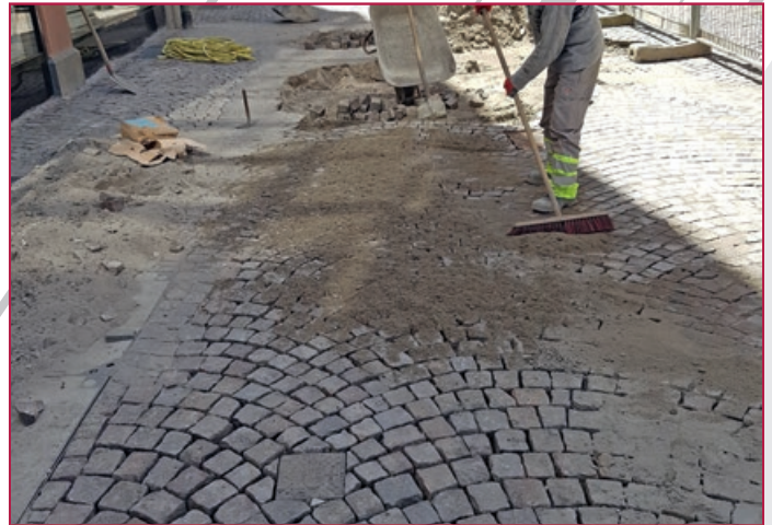
Auffüllen der Fuge | Filling the joints
