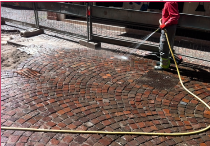
Reinigung der Steinoberfläche | Cleaning the stone surface
